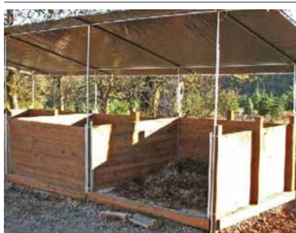
Fig. 70. Aspect platformă individuală impermeabilă cu baza din lemn pe folie de plastic cu acoperiș din tablă zincată
