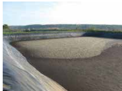
Fig. 54. Rezervor - batal pe bază de geomembrană
