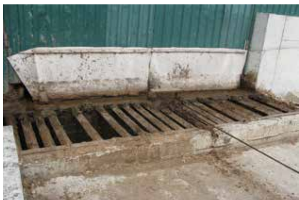
Fig. 50. Grila fosei intermediare pentru dejeții lichide la ieșirea din adăpost
