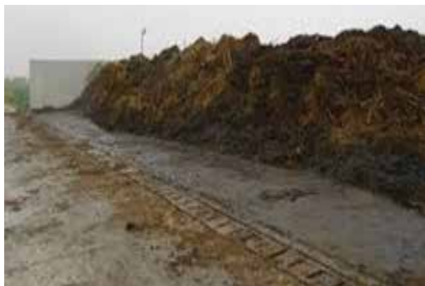
Fig. 71. Platformă individuală de beton în câmp
