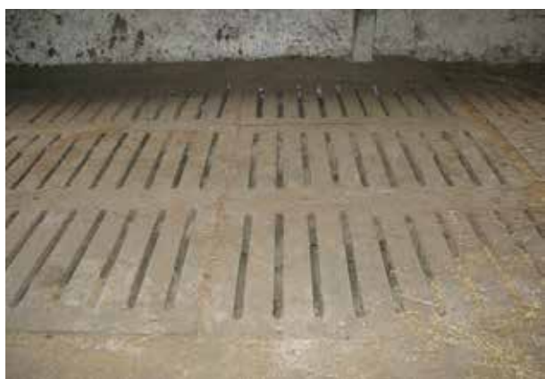
Fig. 42-43. Pardoseală discontinuă – grătare de beton vedere generală (stânga) și modul de amplasare în zona de defecație (dreapta)
