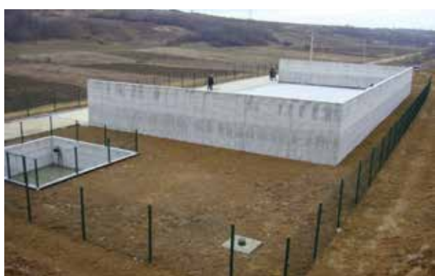
Fig. 57. Aspect amplasare și elementele exterioare ale platformei p/u gunoiul de grajd Sursa: https://www.lumeasatului.ro
