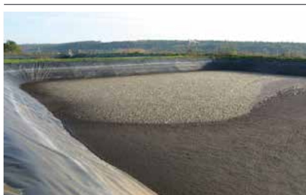
Fig. 61. Rezervorului batal pe bază de geomembrană funcțional
