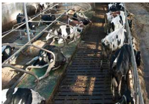
Fig. 42-43. Pardoseală discontinuă – grătare de beton vedere generală (stânga) și modul de amplasare în zona de defecație (dreapta)
