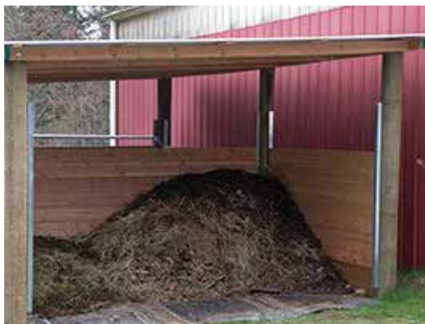
Fig. 62. Aspect platformă individuală pe geomembrană cu un singur compartiment
