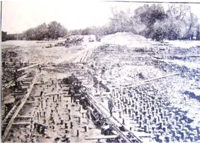
Execuția temeliei barajului de la Filipoiu
