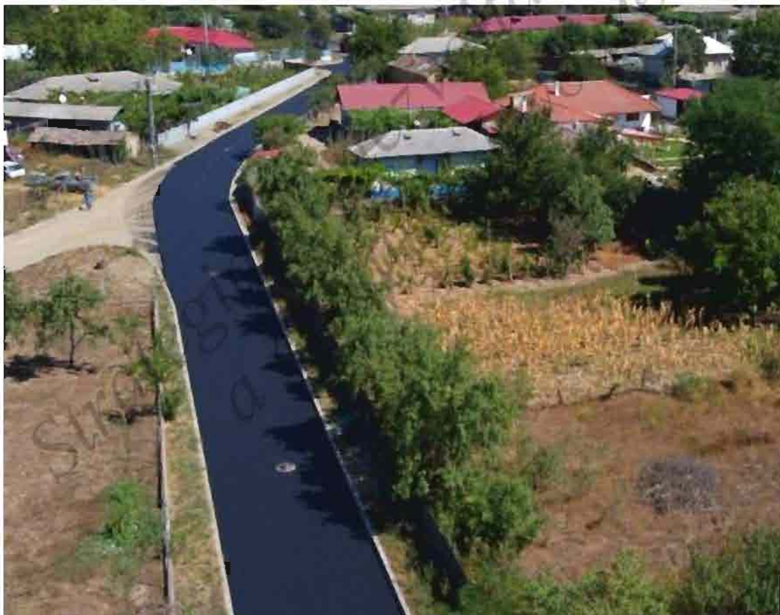
Figura nr. 51. Lucrări pentru modernizarea drumurilor din satul Izvoarele
