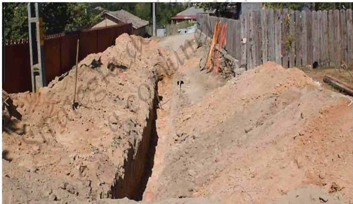
Figura nr.57. Lucrări de extindere și modernizare a sistemului de canalizare din satul Izvoarele
